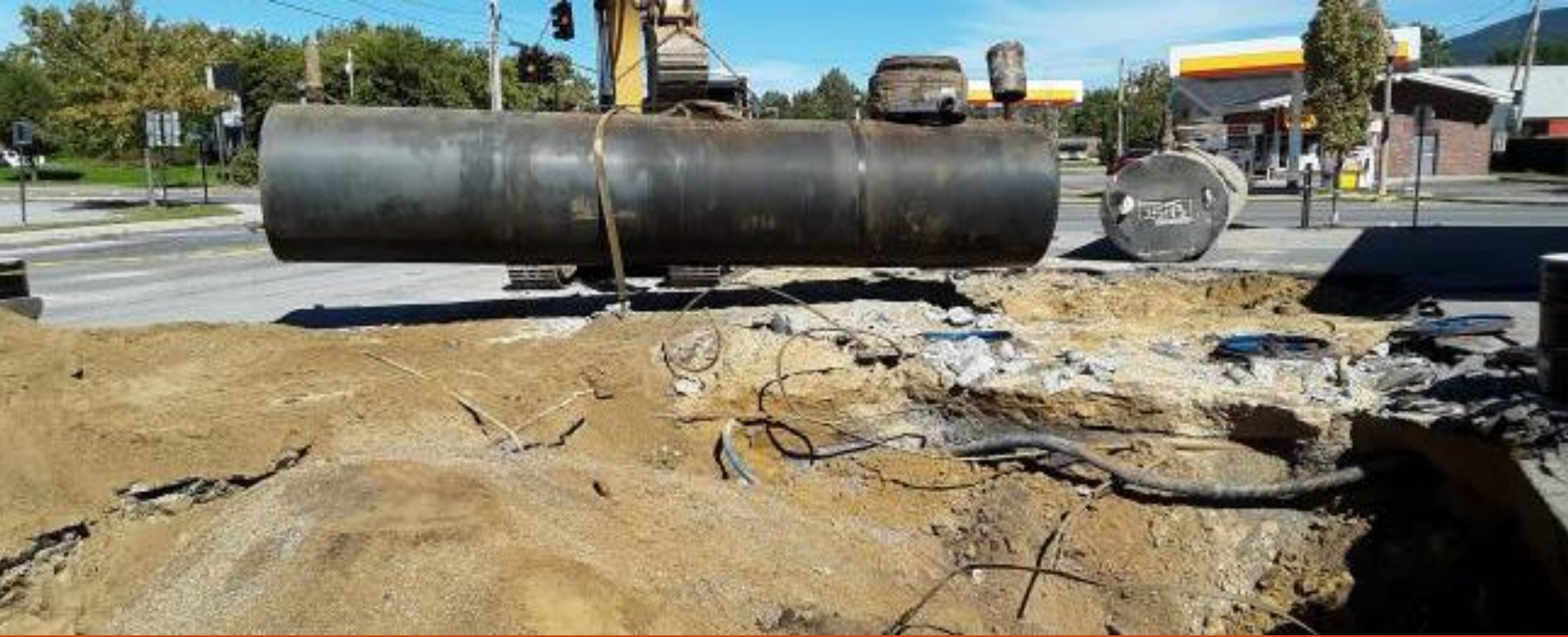
Mini Mart - Gasoline UST Removal (2021)
