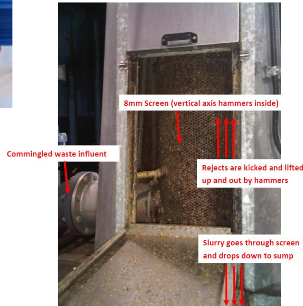
Vertical Bioseparator (Doda)
